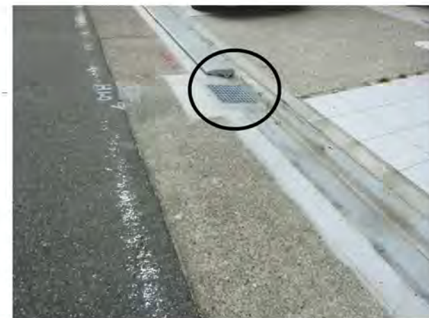
工事施工前（写真上）と工事施工後（写真下） 丸印は雨水枡の設置された場所
