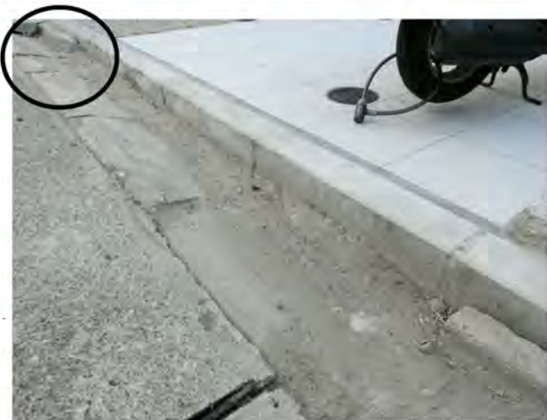
工事施工前（写真上）と工事施工後（写真下） 丸印は雨水枡の設置された場所
