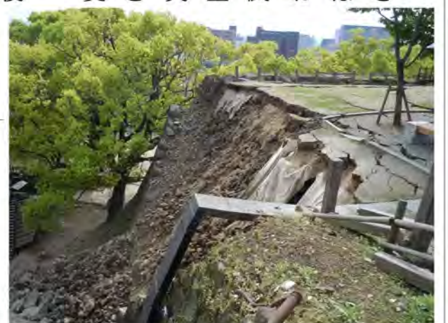
崩壊した熊本城石垣
