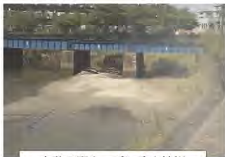
土砂の溜まっている山崎川
